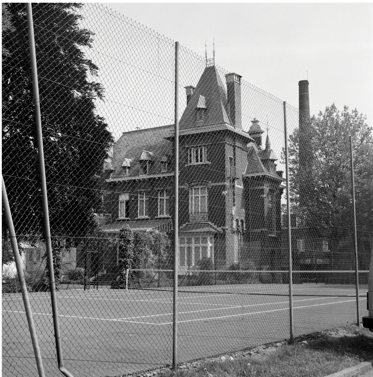
Logement patronal. Élévation postérieure.
