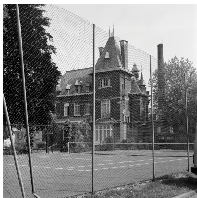
Logement patronal. Élévation postérieure. Phot. Philippe Dapvril IVR31_19885900862X
