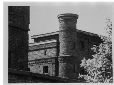
Escalier hors-œuvre d'angle. In GRENIER, Lise, WIESER-BENEDETTI, Hans. Les châteaux de l'industrie. Paris-Bruxelles, 1979, p. 306. Repro. Olivier Marlard IVR31_19895901384Z
