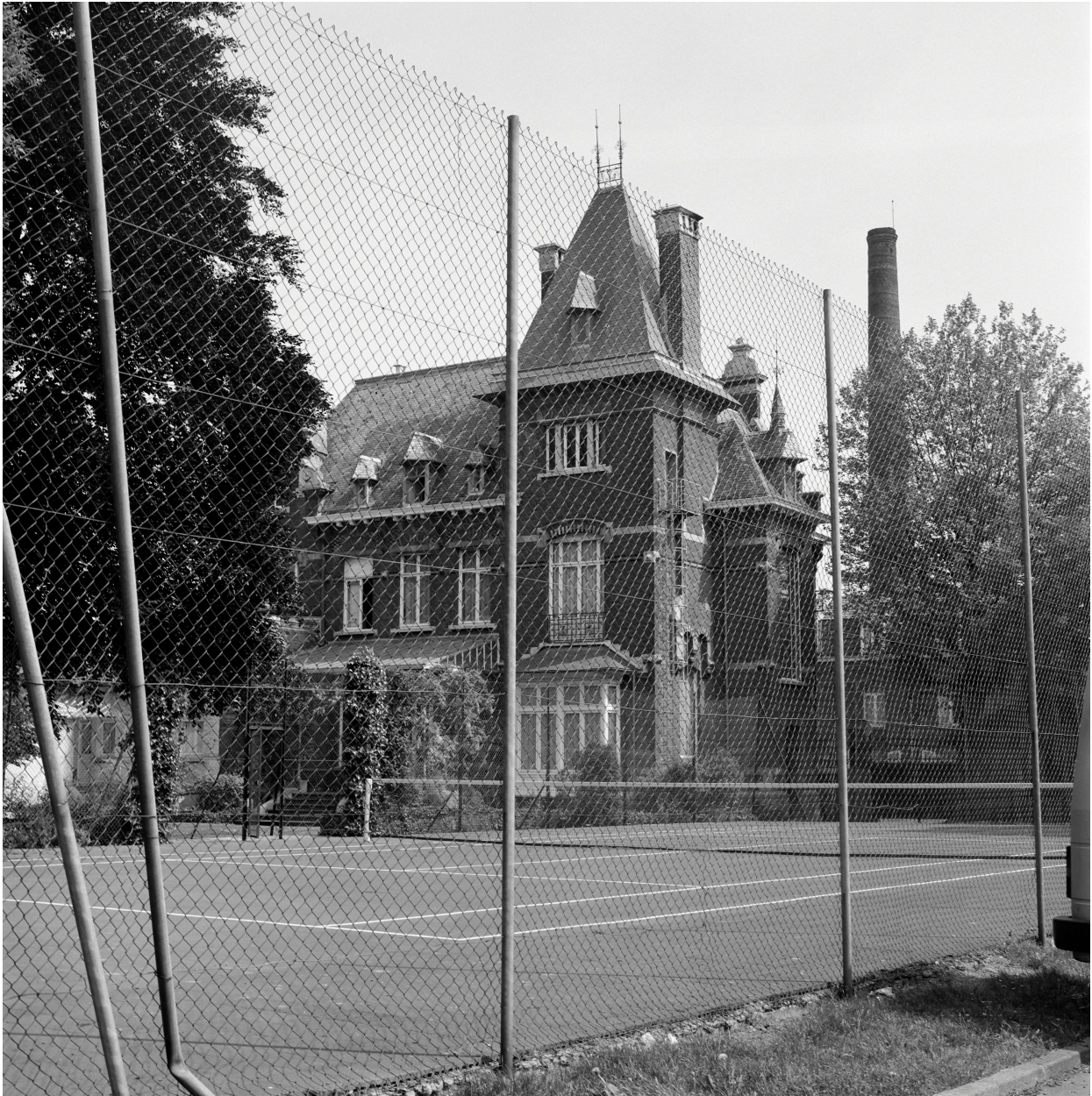
Logement patronal. Élévation postérieure.
