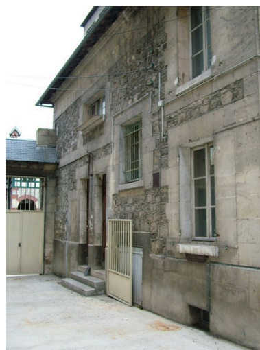
Vue des bureaux depuis la cour intérieure. Phot. Irwin Leullier IVR22_20050200960NUCA
