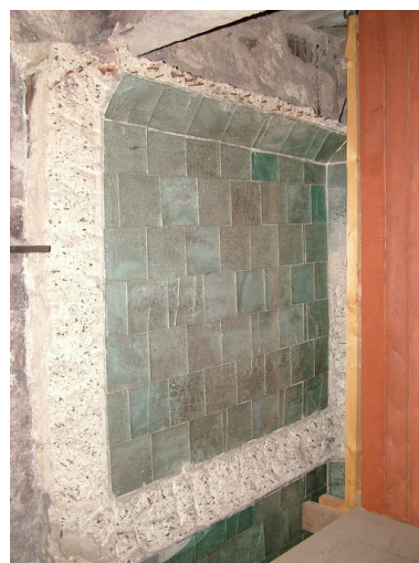
Vue des cuves de stockages détruites. Phot. Irwin Leullier IVR22_20050200957NUCA
