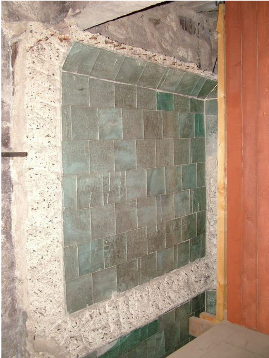
Vue des cuves de stockages détruites.
