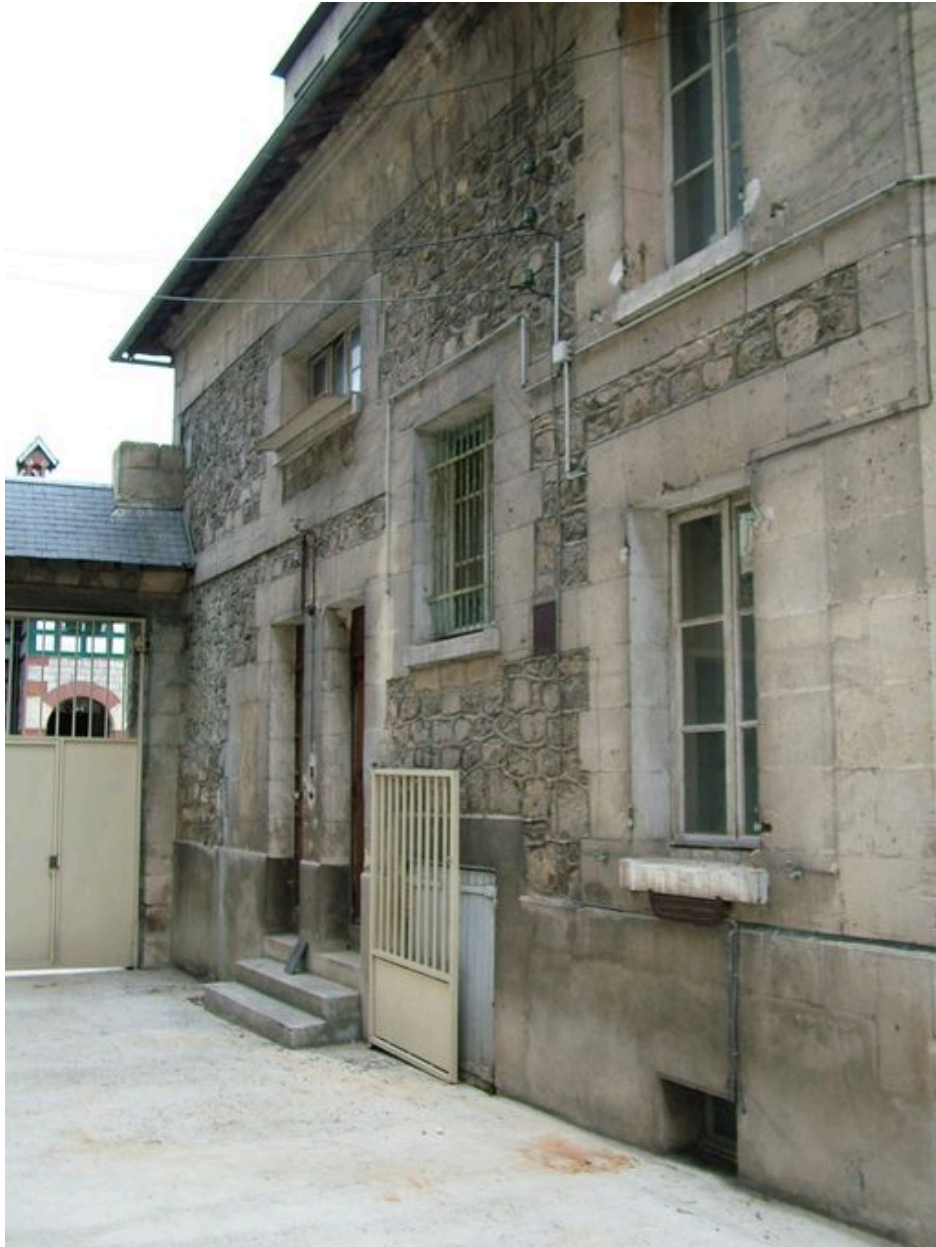
Vue des bureaux depuis la cour intérieure.
