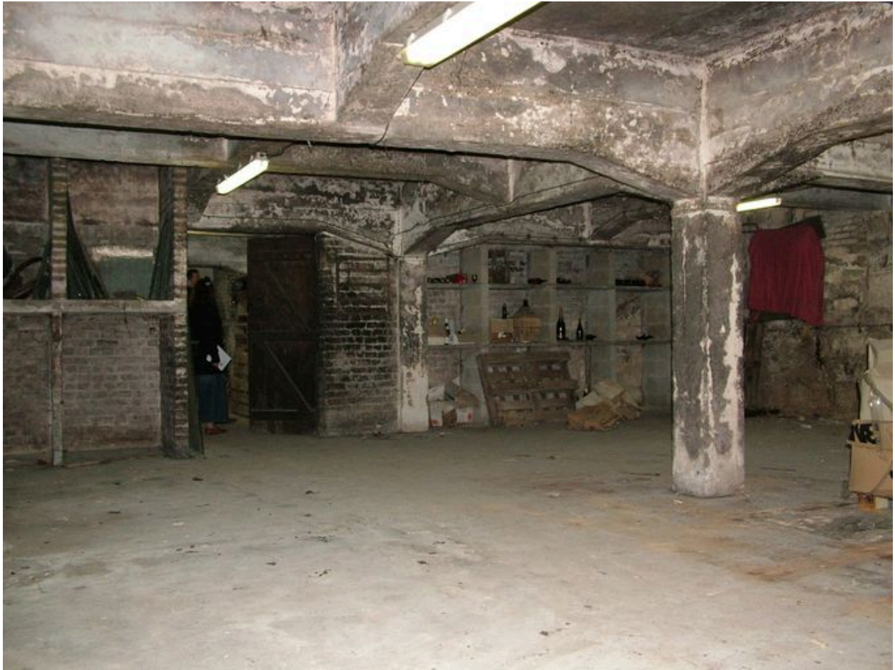
Vue des caves.
