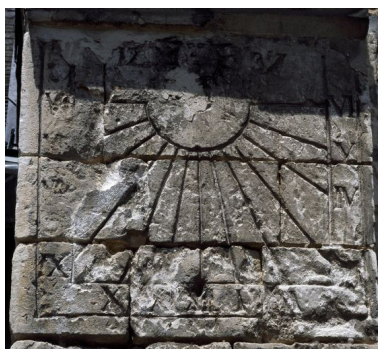
Cadran solaire sculpté sur un des contreforts sud de la nef, portant la date de 1737. Phot. Marie-Laure Monnehay-Vulliet IVR22_20098000158XA
