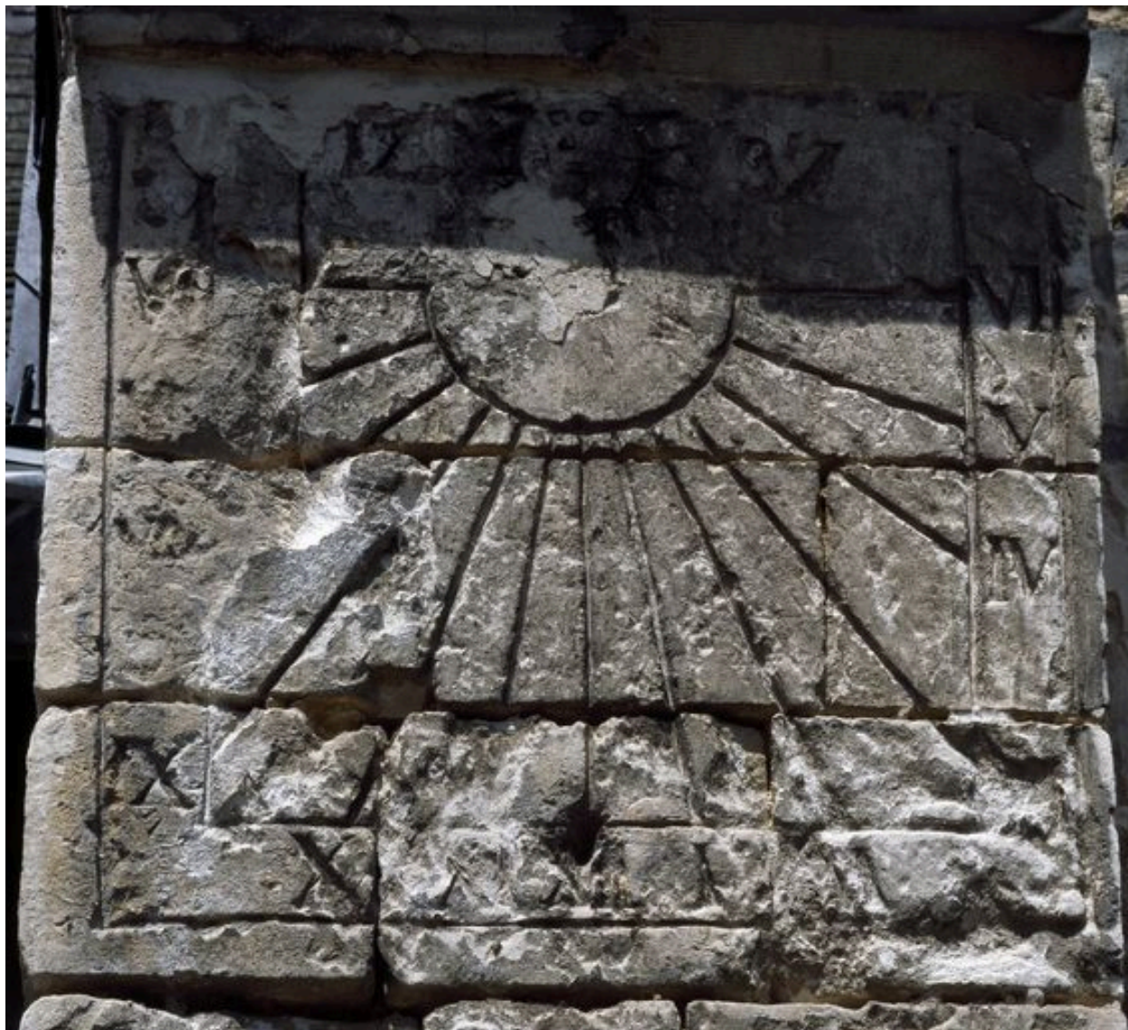
Cadran solaire sculpté sur un des contreforts sud de la nef, portant la date de 1737.
