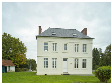
Vue générale. Élévation postérieure. Phot. Pierre Thibaut IVR22_20226200365NUCA
