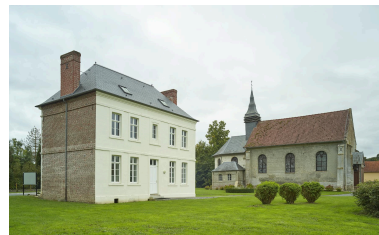
Élévation postérieure vue de côté avec l'église Saint- Martin en arrière-plan. Phot. Pierre Thibaut IVR22_20226200366NUCA
