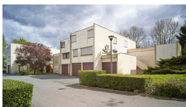
Premier bloc (n° 2) à l'entrée de l'allée des Chamois. Les garages sont intégrés. Les entrées, localisées sur le côté des blocs, sont rendues presque invisibles.
