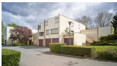
Premier bloc (n° 2) à l'entrée de l'allée des Chamois. Les garages sont intégrés. Les entrées, localisées sur le côté des blocs, sont rendues presque invisibles.
