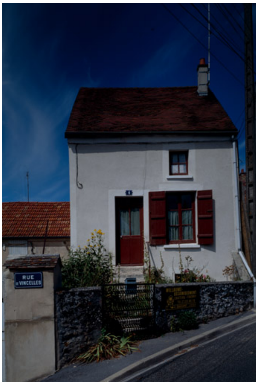
Vue d'ensemble depuis la rue.
