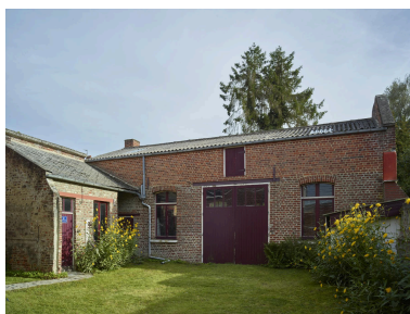
Vue de l'atelier situé au fond de la cour. Phot. Pierre Thibaut IVR32_20245900926NUCA
