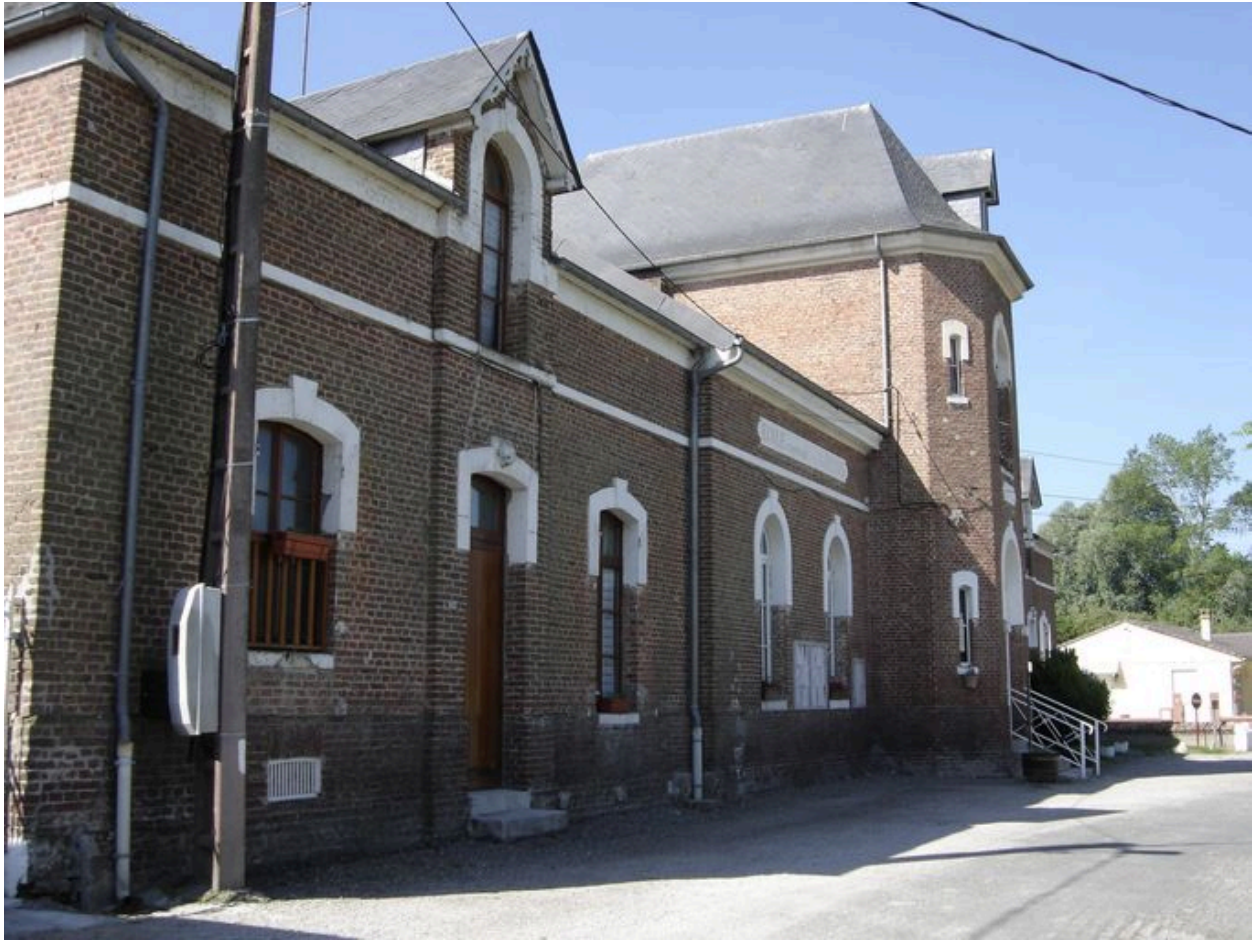
Vue sur l'aile sud.
