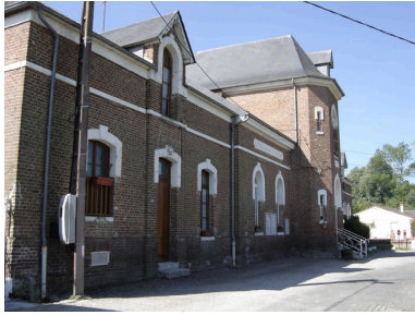
Vue sur l'aile sud. Phot. Catherine Fourmond IVR22_20058001580NUCA
