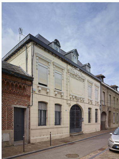
Ancienne banque B.L.D.C., vue générale de la façade principale depuis la rue de la Couronne. Vue orientée est - ouest. Phot. Pierre Thibaut IVR32_20245900328NUCA
