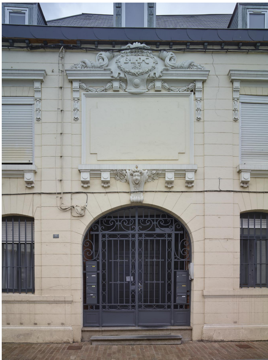
Ancienne banque B.L.D.C., détail de porte monumentale. Vue générale de la façade principale depuis la rue de la Couronne. Vue orientée est - ouest.
