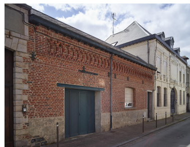
Vue générale de la banque et des communs. Vue orientée sud-est - nord-ouest. Phot. Pierre Thibaut IVR32_20255900750NUCA
