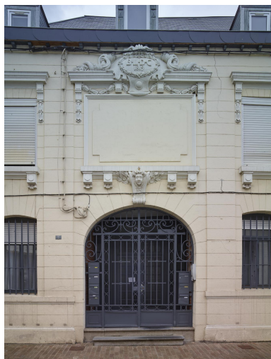
Ancienne banque B.L.D.C., détail de porte monumentale. Vue générale de la façade principale depuis la rue de la Couronne. Vue orientée est - ouest. Phot. Pierre Thibaut IVR32_20245900324NUCA
