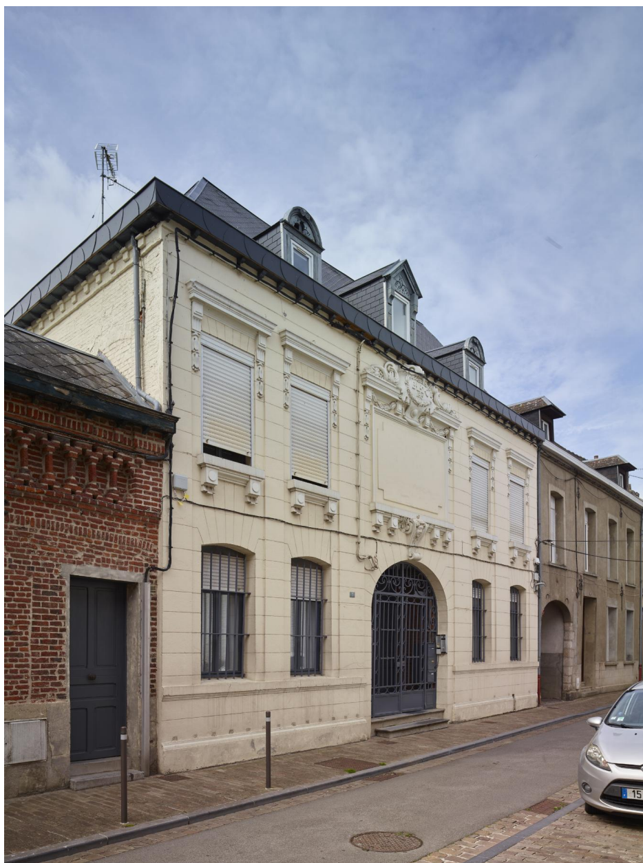
Ancienne banque B.L.D.C., vue générale de la façade principale depuis la rue de la Couronne. Vue orientée est - ouest.
