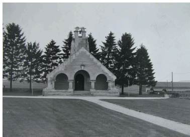
Vue de la chapelle lors de la construction (coll. part). Phot. In s Gu rin IVR22_20050200659NUCAB
