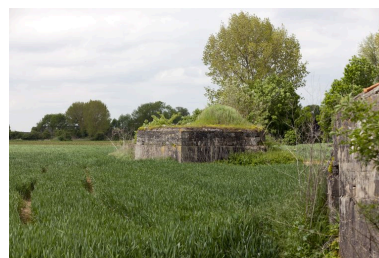
Vue des deux blockhaus d'artillerie (IA59004812 au fond). Phot. Jean-Marc Ramette IVR31_20145904330NUCA
