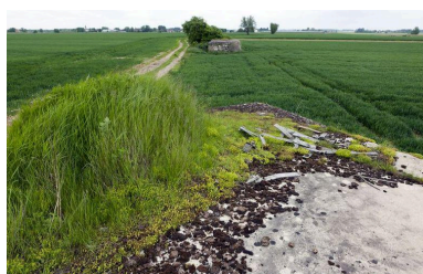
Vue des deux blockhaus d'artillerie en enfilade (IA59004814 au fond) Phot. Jean-Marc Ramette IVR31_20145904340NUCA
