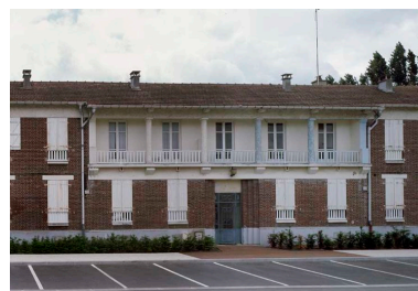
Bâtiment 520 : Entrée des logements et détail de la colonnade. Phot. Thierry Lefébure IVR22_20106000429XA
