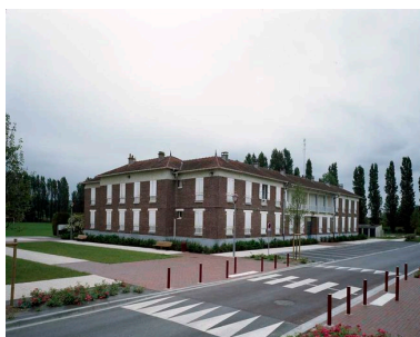
Bâtiment 520 : Vue générale. Phot. Thierry Lefébure IVR22_20106000427VA
