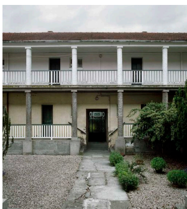
Bâtiment 520 : Elévation intérieure. Phot. Thierry Lefébure IVR22_20106000431XA
