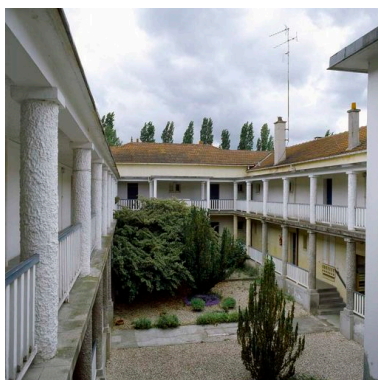
Bâtiment 520 : Vue générale de la cour intérieure. Phot. Thierry Lefébure IVR22_20106000434XA
