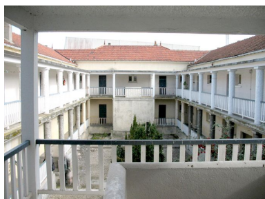
Bâtiment 520 : Cour intérieure du bâtiment pour ouvriers célibataires. Phot. Clarisse Lorieux IVR22_20096005106NUCA
