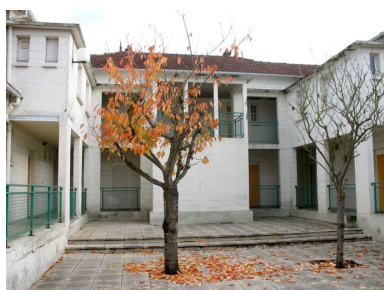
Bâtiment 523 : Cour intérieure. Phot. Clarisse Lorieux IVR22_20096005203NUCA
