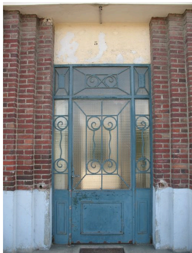
Bâtiment 520 : Porte d'entrée. Phot. Clarisse Lorieux IVR22_20096005163NUCA
