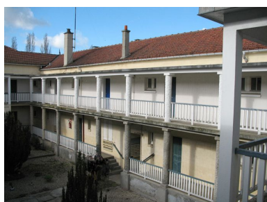
Bâtiment 520 : Détail de la coursive intérieure. Phot. Clarisse Lorieux IVR22_20096005108NUCA
