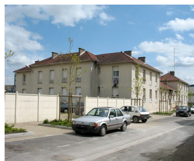
Bâtiment 523 : Logements pour ouvriers célibataires près de la cité de la Colorante. Phot. Clarisse Lorieux IVR22_20096005112NUCA
