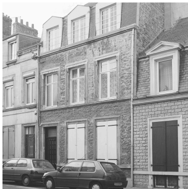
Façade sur voie. Phot. Michèle Rougier IVR22_19956200836X
