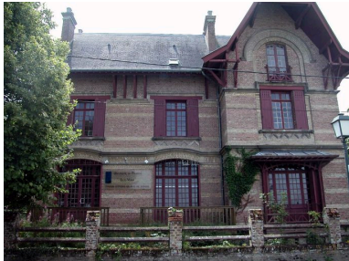
Vue d'ensemble depuis la digue.
