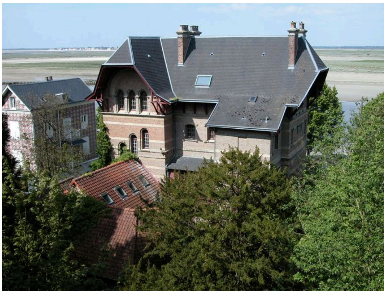
Vue d'ensemble depuis les fortifications de la Ville-Haute.
