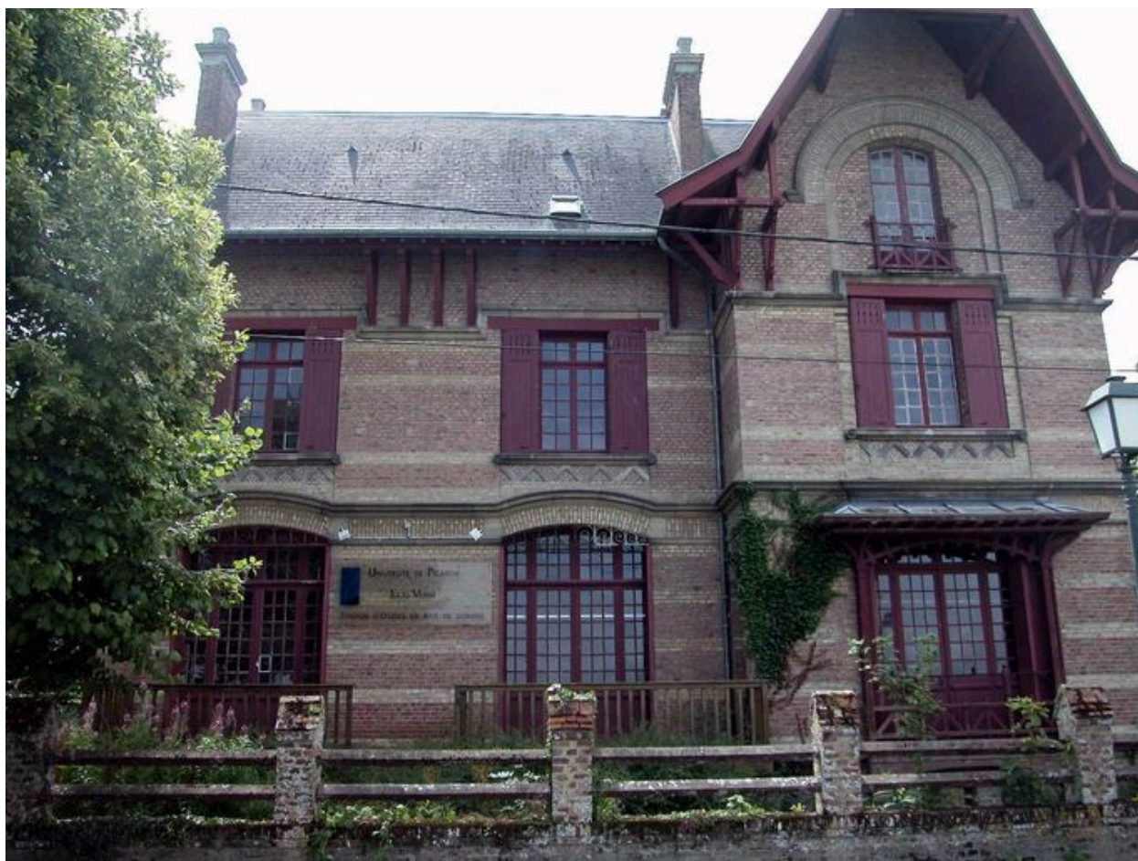
Vue d'ensemble depuis la digue.
