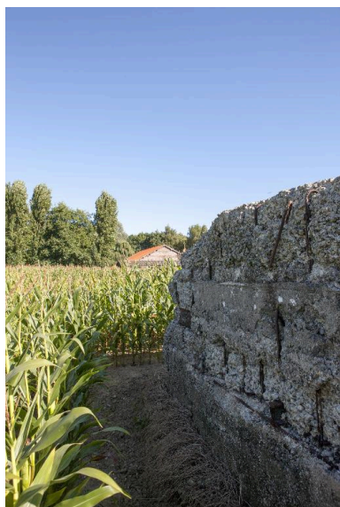
Elévation nord, vers l'est Phot. Pierre Thibaut IVR32_20165901331NUCA
