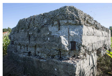
Elévations sud et ouest (dans l'ombre) Phot. Pierre Thibaut IVR32_20165901328NUCA
