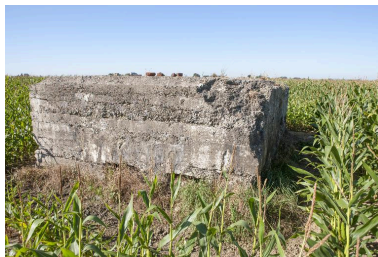
Elévations est et nord (dans l'ombre) Phot. Pierre Thibaut IVR32_20165901333NUCA
