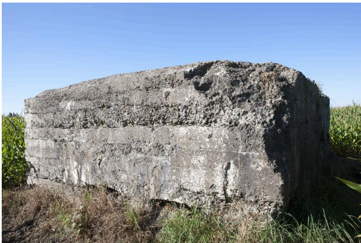
Elévations est et nord (dans l'ombre)
