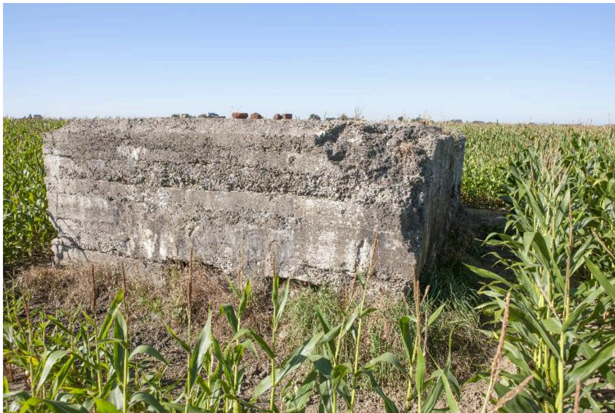
Elévations est et nord (dans l'ombre)
