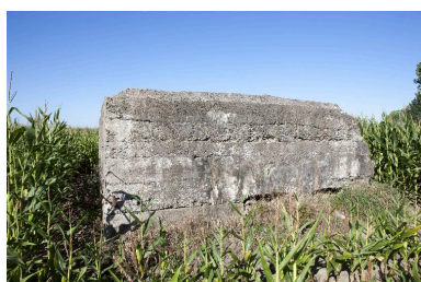
Elévation est Phot. Pierre Thibaut IVR32_20165901327NUCA
