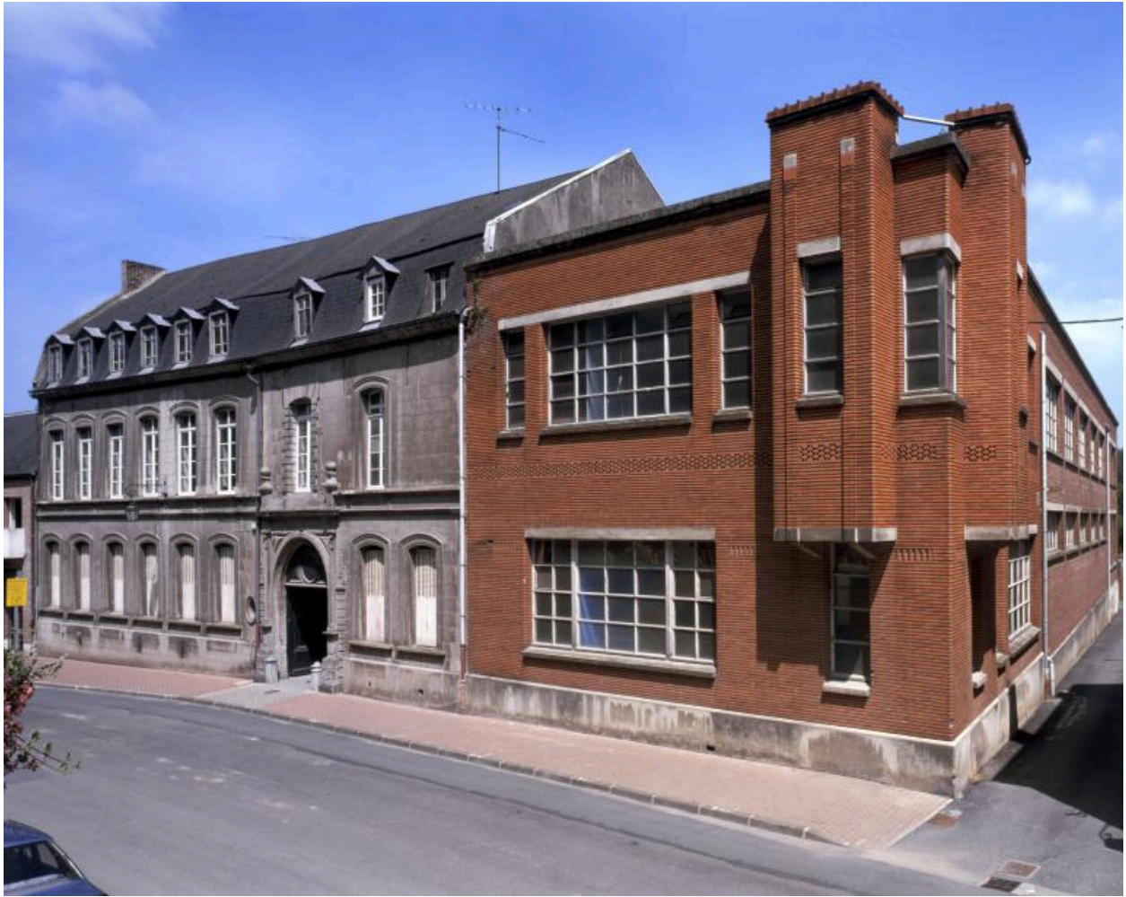
Vue générale de la façade sur rue de l'ancien bailliage ducal, flanquée, à droite, du bâtiment de brique construit en 1936 par Jean Canonne à l'emplacement de l'hôtel de ville détruit.
