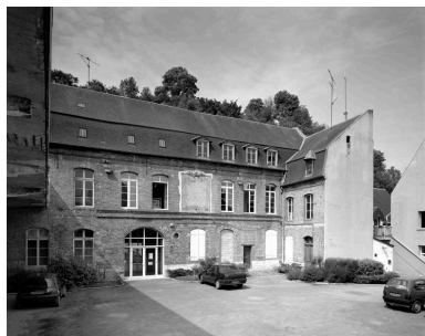
Vue des façades sur cour de l'ancien bailliage ducal. Phot. Thierry Lefébure IVR22_19990202179V
