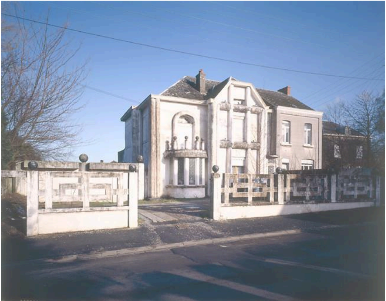
Élévation antérieure depuis la rue.
