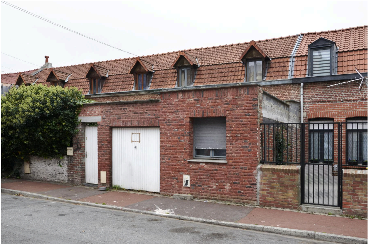
Vue générale de la rue.
