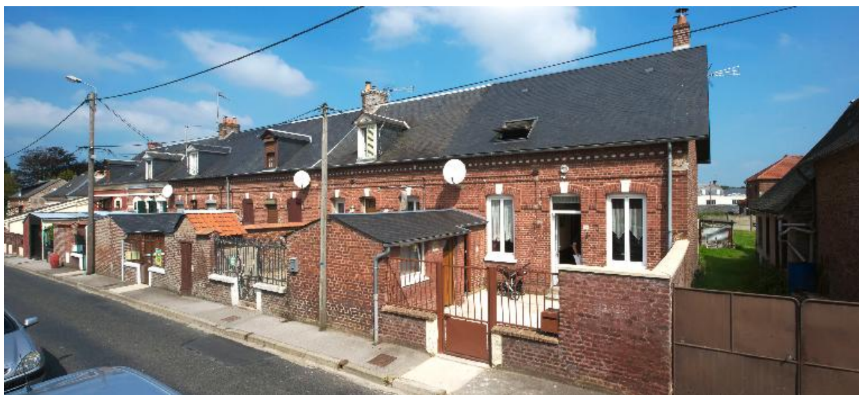
Vue générale depuis le sud.
