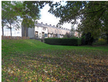
Vue des façades arrières des logements. Phot. Isabelle Barbedor IVR22_20148005194NUC2A
