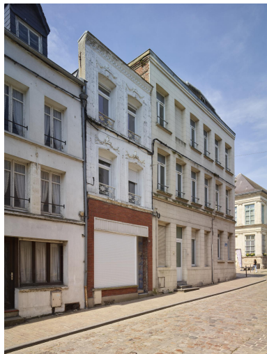
Façade plaquée vue de profil : la partie de la façade qui débord de la toiture est bien visible. Vue orientée nord-ouest/sud-est. Phot. Pierre Thibaut IVR32_20235901039NUCA
