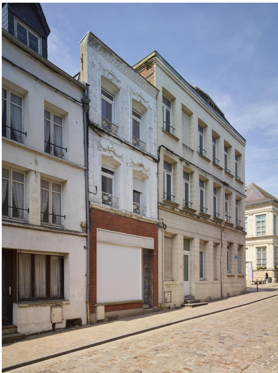
Façade plaquée vue de profil : la partie de la façade qui déborde de la toiture est bien visible. Vue orientée nord-ouest/sud-est.
