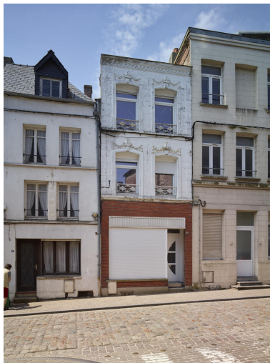
Façade vue de face. Phot. Pierre Thibaut IVR32_20235901035NUCA
