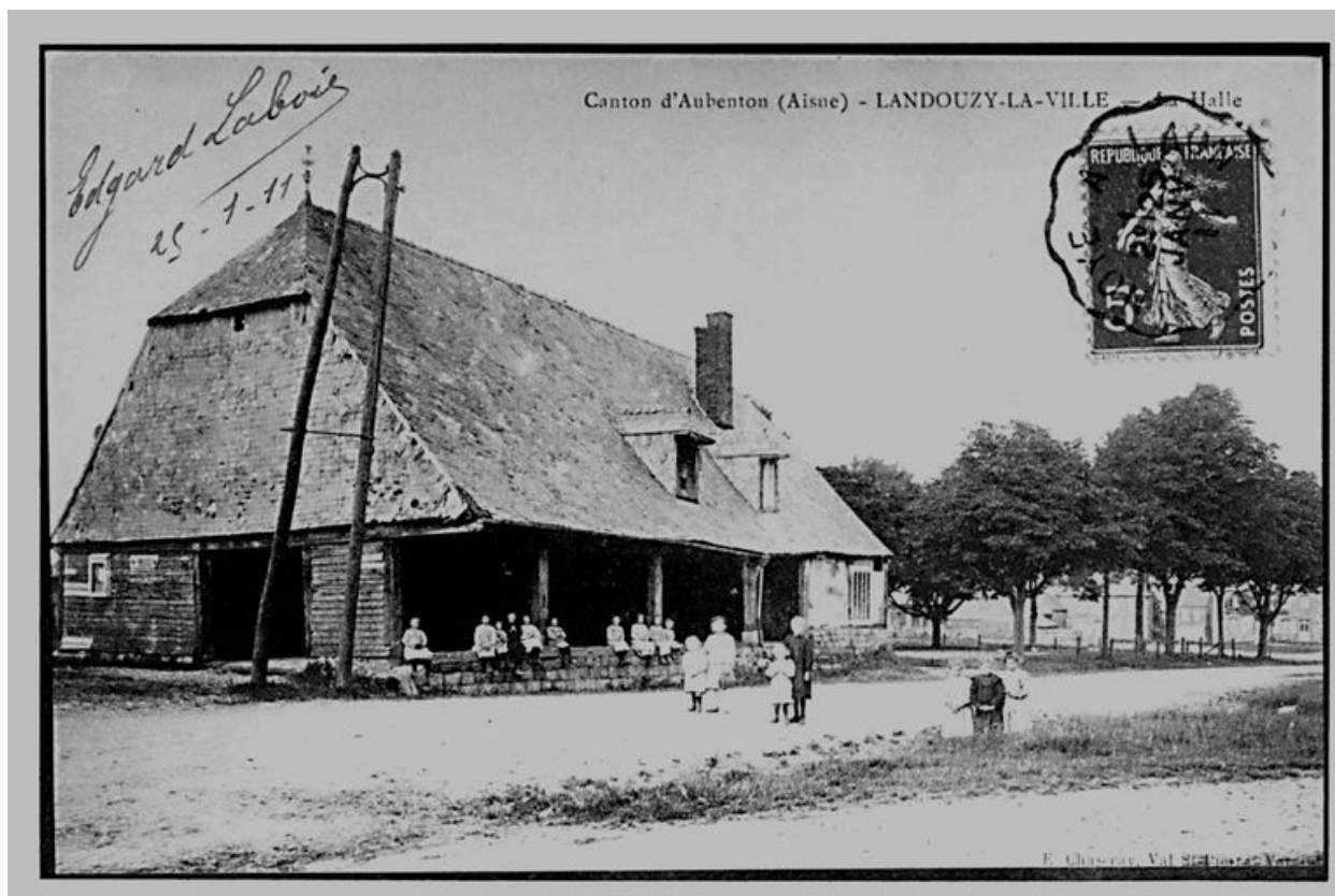
Vue ancienne depuis le sud-ouest (coll.part).
