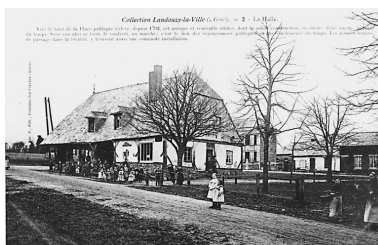
Vue depuis le sud-est de la halle démontée en 1923. (AP). Phot. Laurent Jumel (reproduction) IVR22_19970201306ZB
