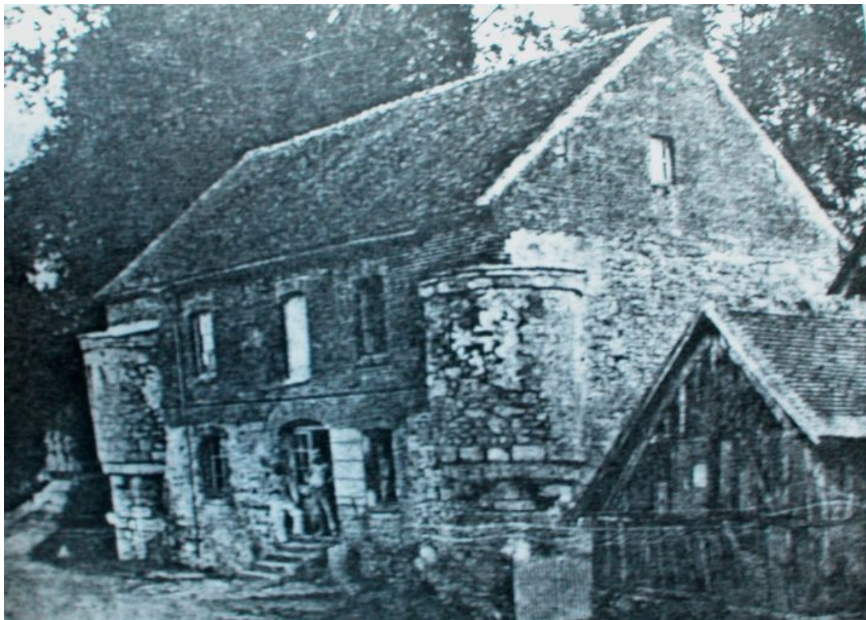
Vue d'ensemble du moulin en 1900.
