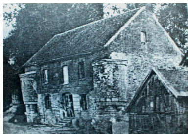
Vue d'ensemble du moulin en 1900.
