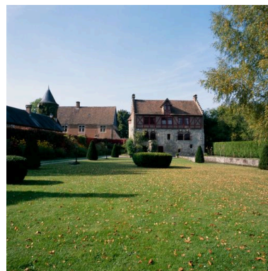
Vue d'ensemble de la façade postérieure sur jardin. Phot. Thierry Lefébure IVR22_20026001121XA
