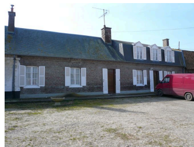
Vue sur le logis en brique et sur les écuries qui lui sont attenantes. Phot. Inès Guérin IVR22_20058001614NUCA
