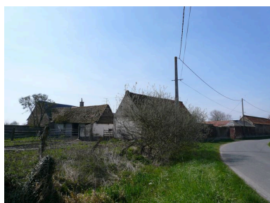
Vue postérieure des étables à l'est. Phot. Inès Guérin IVR22_20058001612NUCA
