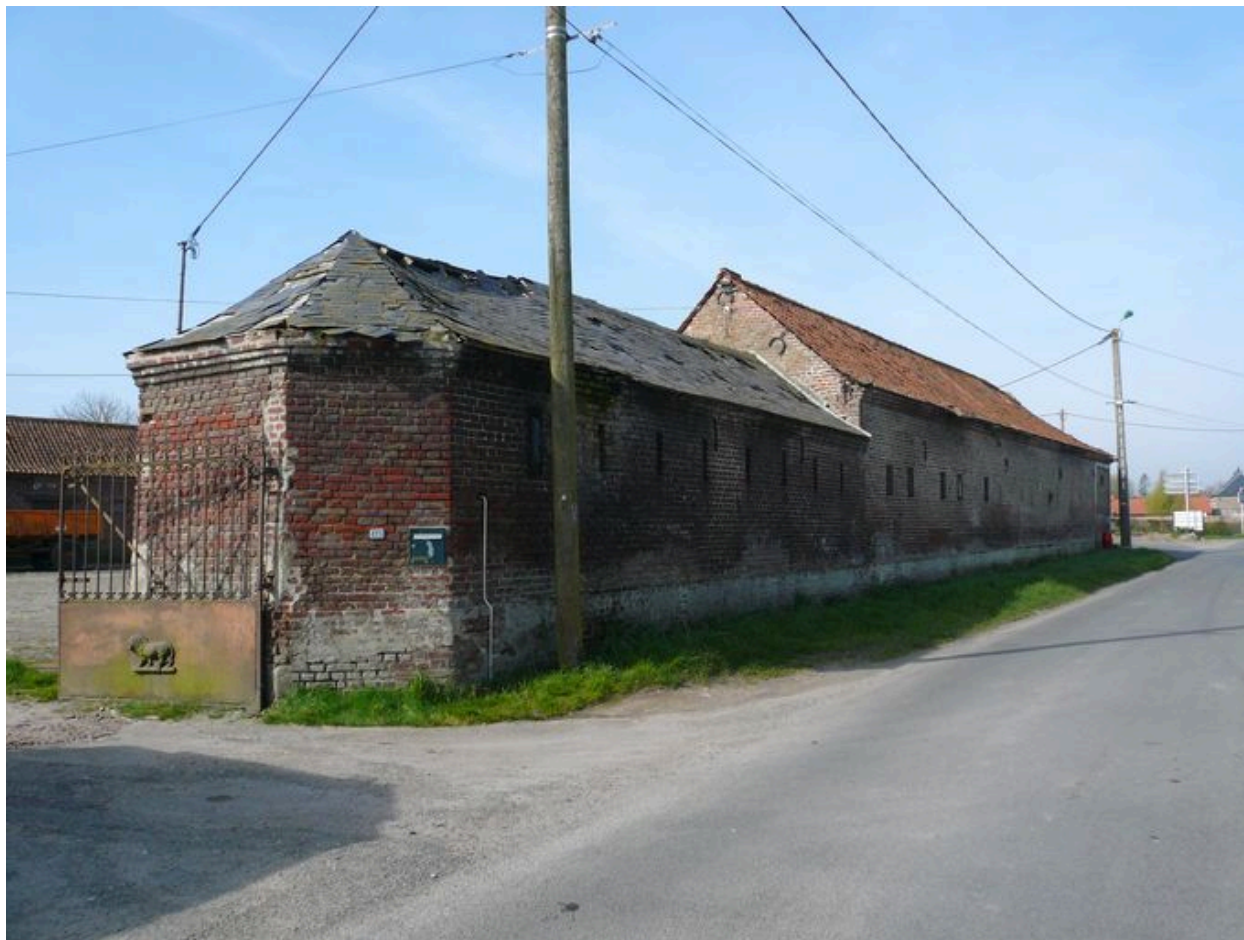
Vue sur les étables depuis la rue datées par les ancrs de 1900 et sur l'entrée principale.
