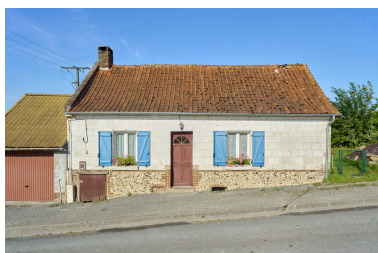
Vue de la maison, depuis l'est. Phot. Thierry Lefébure IVR32_20258001372NUCA
