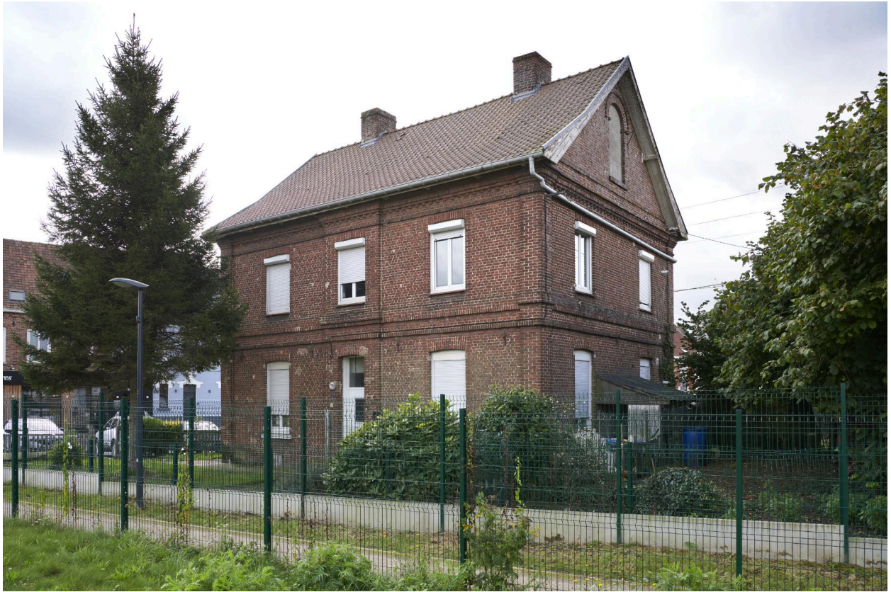
Vue du bâtiment depuis la voie ferrée.
