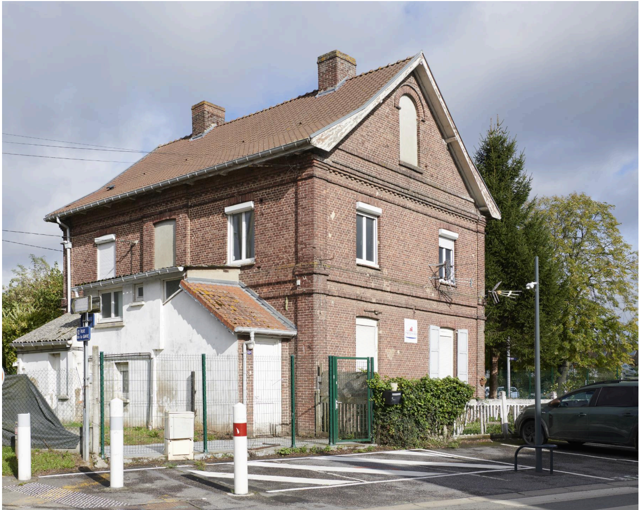
Pignon sur rue et côté gauche du bâtiment.
