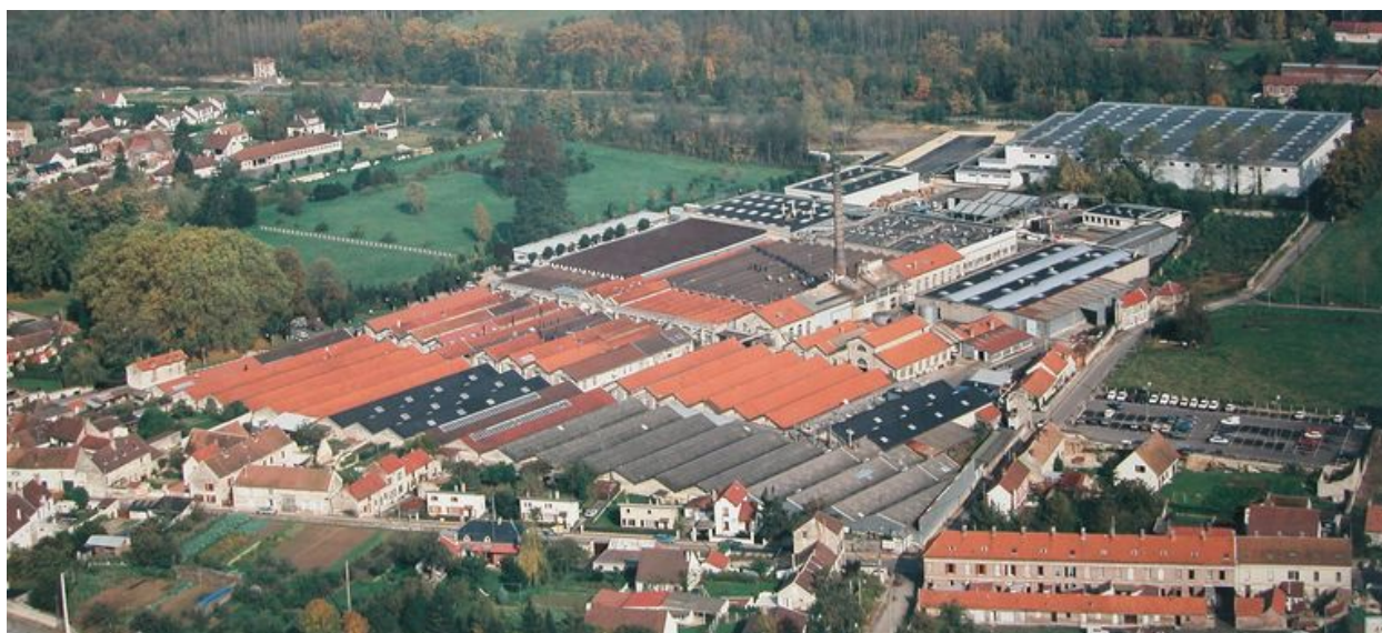
Vue aérienne de l'usine.
