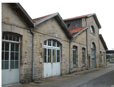
Magasin et atelier de mécanique. Phot. Bertrand Fournier IVR22_20046003178NUCA
