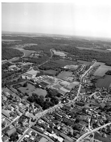
Vue aérienne de l'usine en 1995. Phot. Phot'R IVR22_19956000864X
