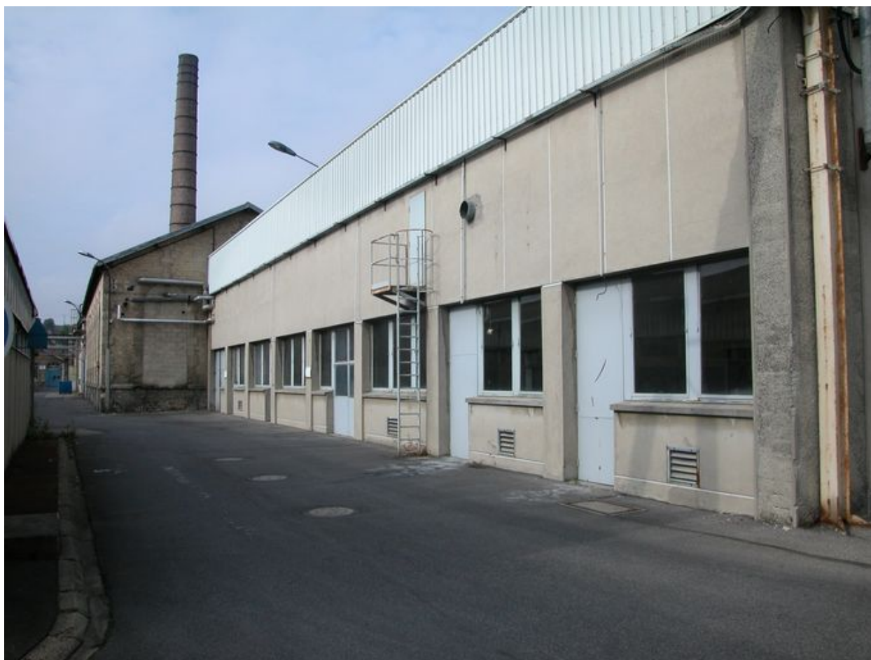
Atelier de fabrication moderne avec la chaufferie à l'arrière.
