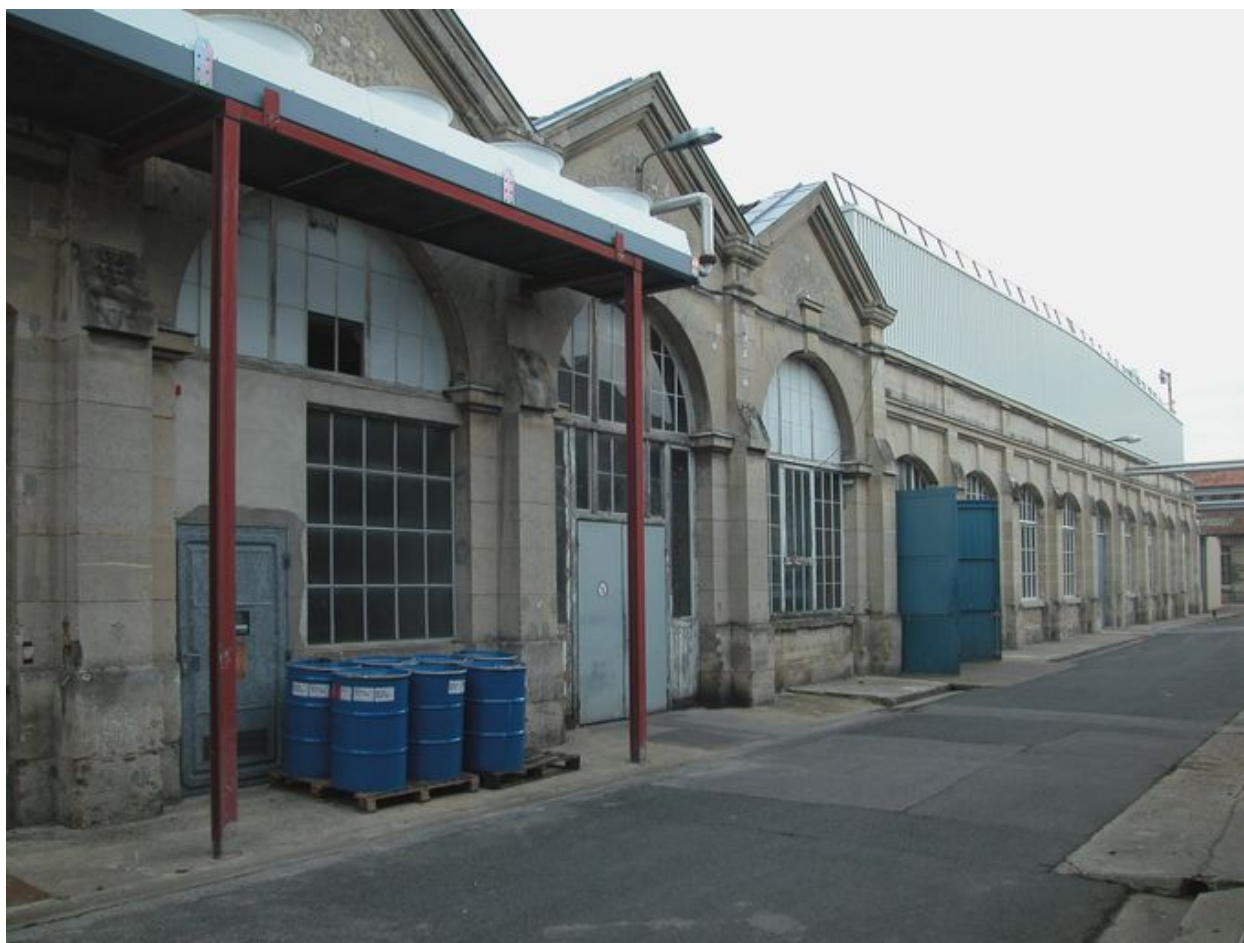
Vue partielle des ateliers de fabrication.
