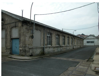
Façade longitudinale d'un des ateliers de fabrication. Phot. Bertrand Fournier IVR22_20046003175NUCA
