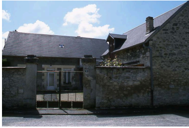
Disposition générale. Phot. Inès Guérin IVR22_20030203235NUCA
