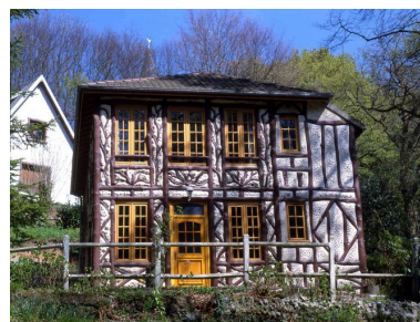
Elévation antérieure. Phot. Marie-Laure Monnehay-Vulliet IVR22_20048000026XA
