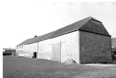
Élévation postérieure de la ferme. Phot. Xavier-Philippe Guiochon IVR22_19980202712Z
