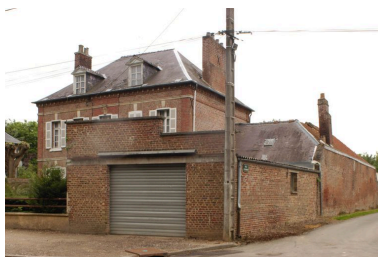
Dépendances bordant le chemin. Phot. Thierry Lefébure IVR22_20038000430NUCA
