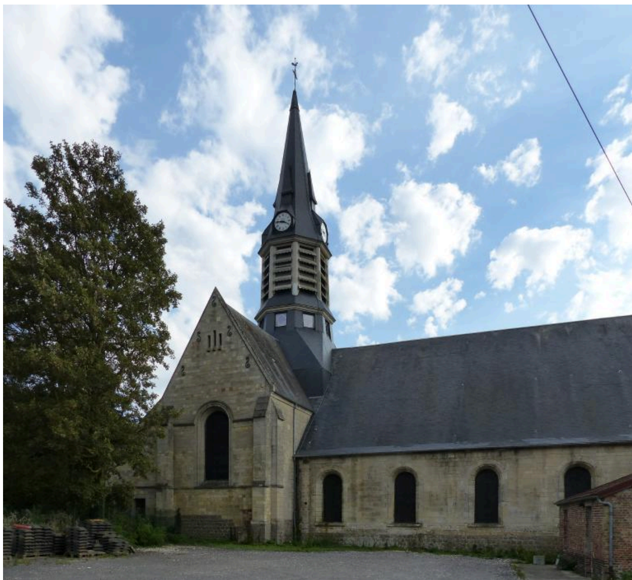
Vue des façades nord.
