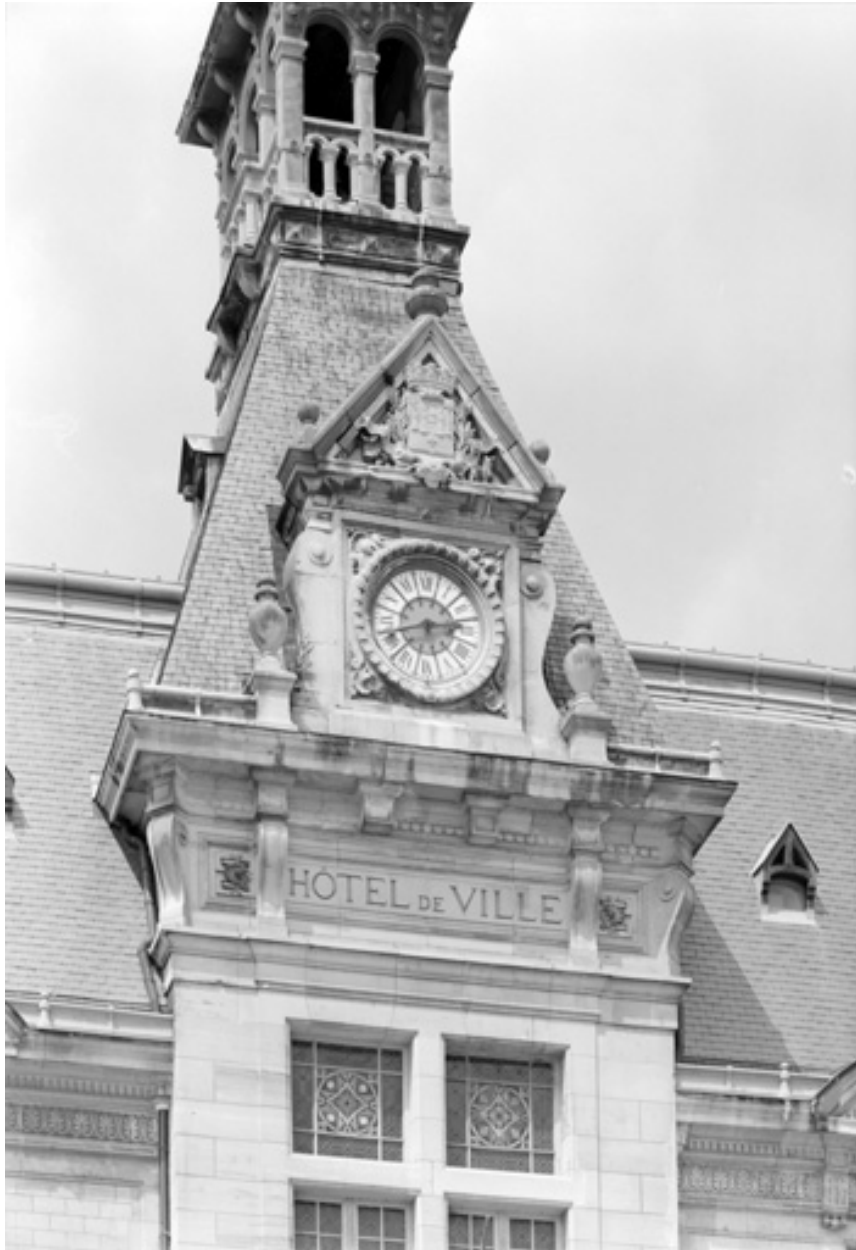
Détail de la façade, l'horloge.
