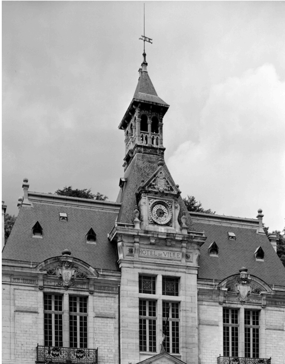
Les parties hautes de la façade, premier étage et toiture.
