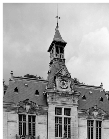
Les parties hautes de la façade, premier étage et toiture. Phot. Thierry Lefébure IVR22_19900201176V
