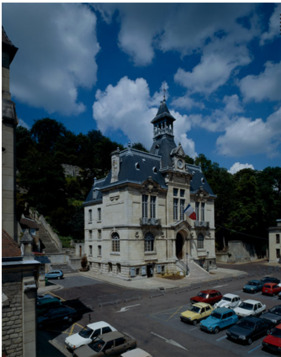
Vue d'ensemble depuis le toit du marché couvert.
