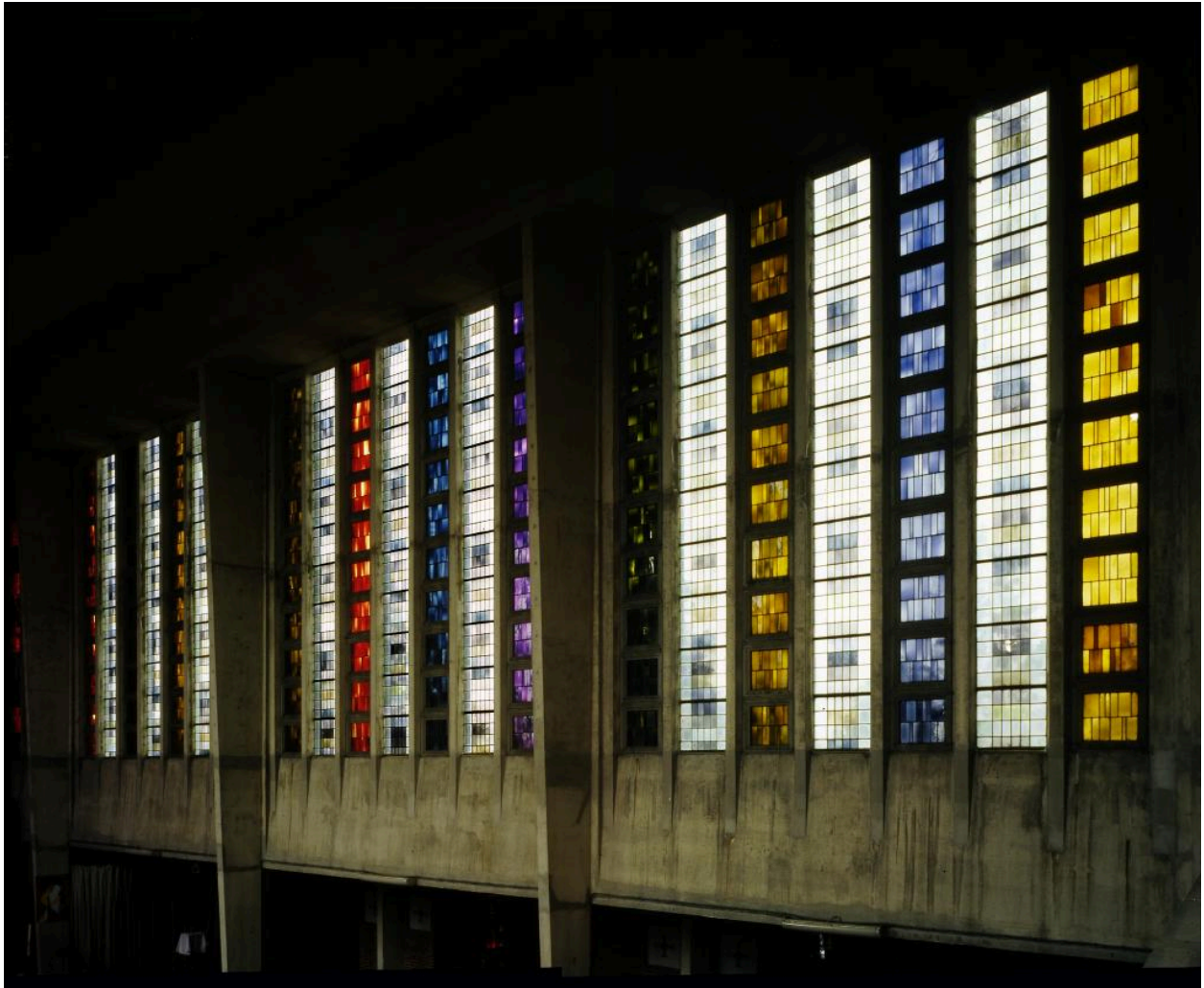
Vue des fenêtres du mur ouest de l'église, depuis la tribune (baies 104, 106, 108).
