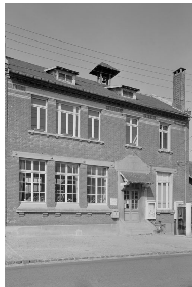
Elévation antérieure. Phot. Jean-Michel Perrin IVR22_19856000575X
