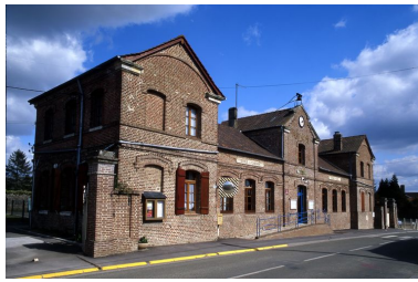
Vue générale. Phot. Marie-Laure Monnehay-Vulliet IVR22_20068000172XA
