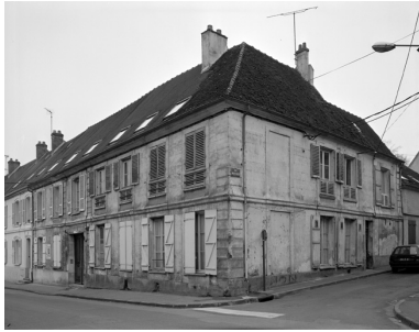
Ancien relais de poste, 18e siècle. Phot. Thierry Lefébure IVR22_19950203240V
