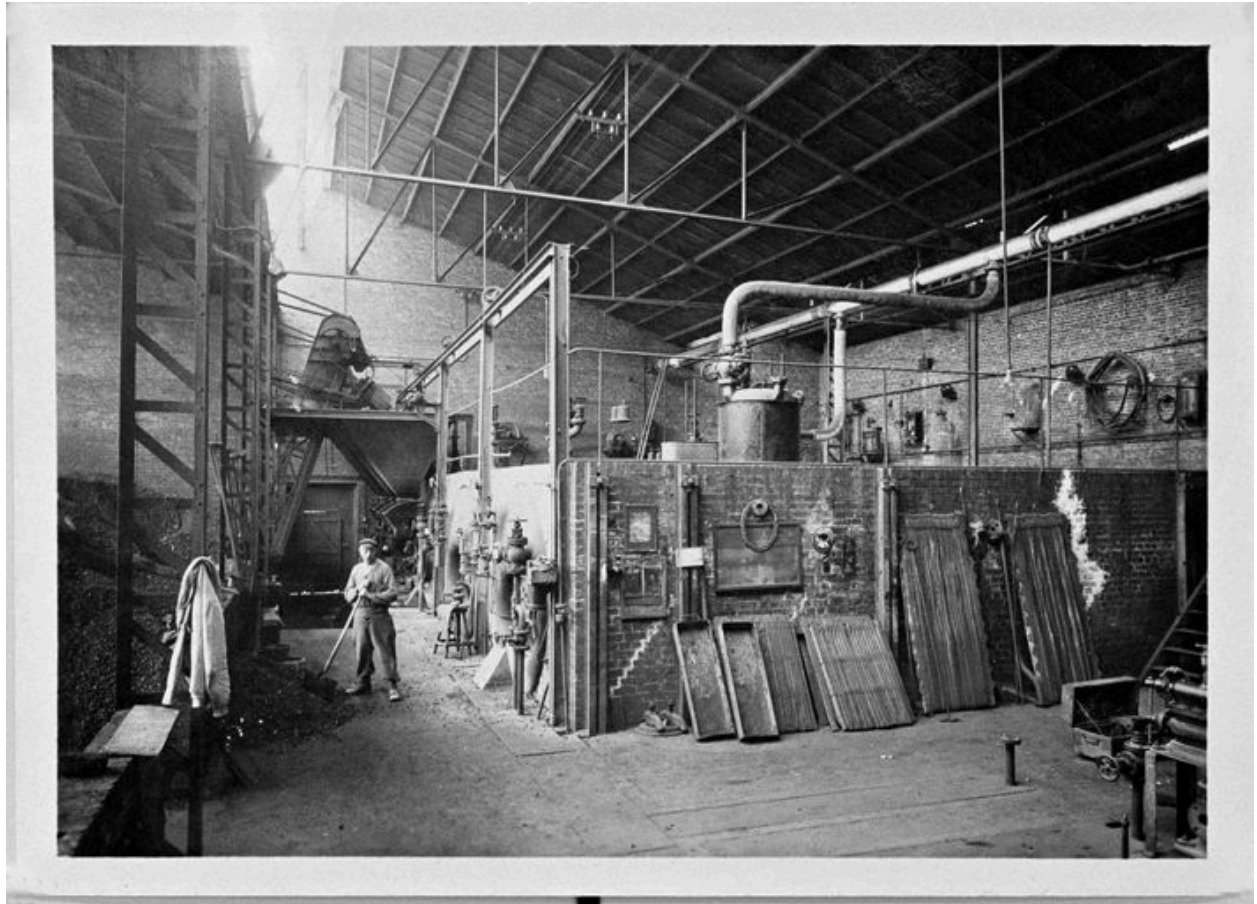
Atelier de fabrication : vue intérieure, vers 1930 (AP).
