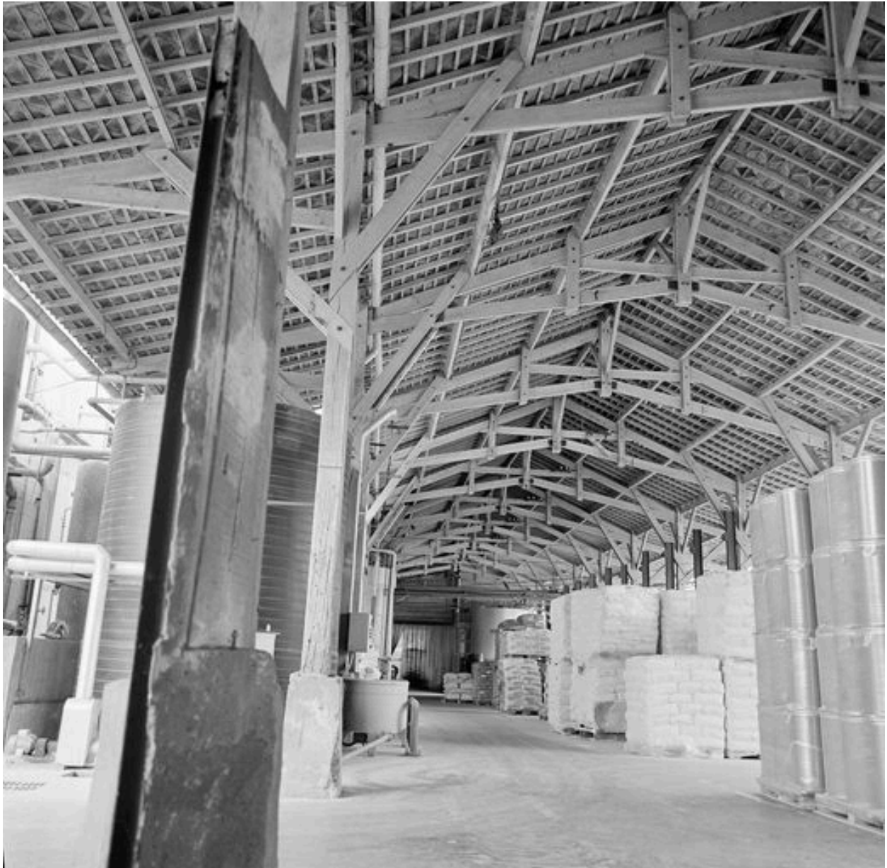
Magasin industriel : vue intérieure.
