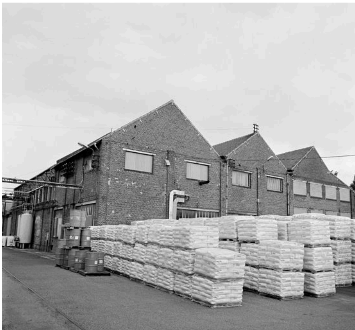
Atelier de fabrication et salle des machines.
