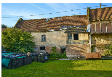
Vue nord de la deuxième maison, depuis la cour. Phot. Thierry Lefébure IVR32_20238000624NUCA
