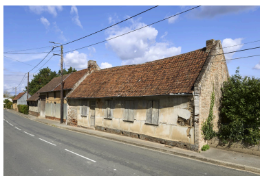
Vue sud-est de la deuxième maison et de son mur pignon, depuis la rue. Phot. Thierry Lefébure IVR32_20238000621NUCA
