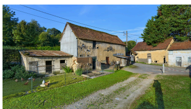
Vue sud-est des bâtiments agricoles, depuis la cour. Phot. Thierry Lefébure IVR32_20238000606NUCA
