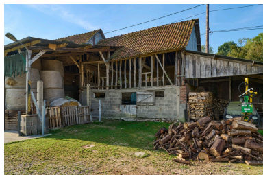
Vue nord des bâtiments agricoles, depuis la cour. Phot. Thierry Lefébure IVR32_20238000629NUCA
