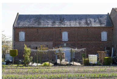
Le relais à chevaux et l'ancienne salle communale, façade nord, n°48 rue Principale. Phot. Marc Kérignard IVR32_20216000313NUCA
