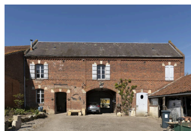
Ancien relais à chevaux (avec écuries au rez-de-chaussée) puis salle communale (1er étage), n°48 rue Principale, vue depuis l'est. Phot. Marc Kérignard IVR32_20216000314NUCA
