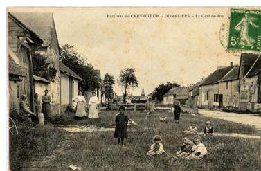
Vue depuis le sud d'une section de la Grande Rue (actuelle rue Principale), vers les n°26-30. Carte postale du 1er quart du 20e siècle (coll. part.).
