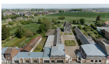
Vue aérienne de situation de l'ensemble des entrepôts, chais et villa depuis la rue du faubourg de Péronne. Phot. Marc Kérignard IVR32_20226200049NUCA
