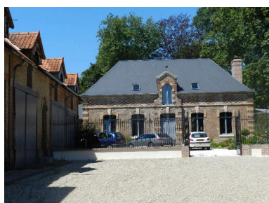
Les communs. Phot. Romain Grimaud IVR22_20128015617NUC1A
