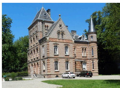
Vue générale. Phot. Romain Grimaud IVR22_20128005270NUCA
