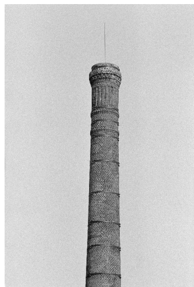
La cheminée d'usine. Phot. Benoît Dufournier IVR22_19878000179Z
