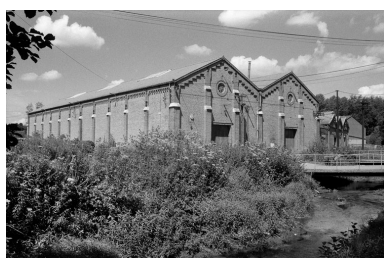
Les magasins industriels, vus depuis le sud-ouest. Phot. Benoît Dufournier IVR22_19878000156Z
