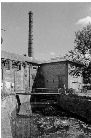
Bureau, bâtiment d'eau.
