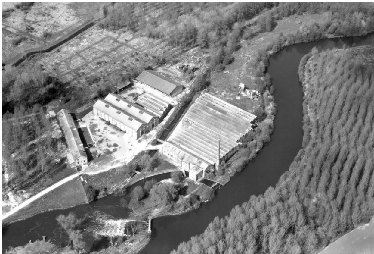
Vue aérienne, flanc sud ouest.
