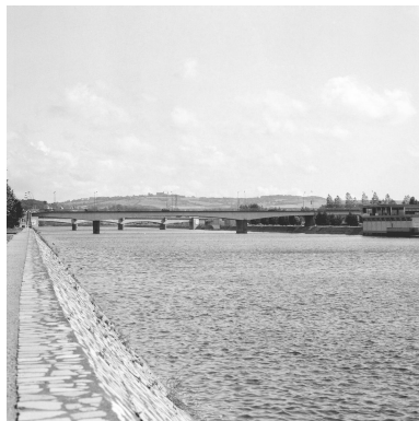
Vue générale nord. Phot. Philippe Dapvril IVR31_19896200737X
