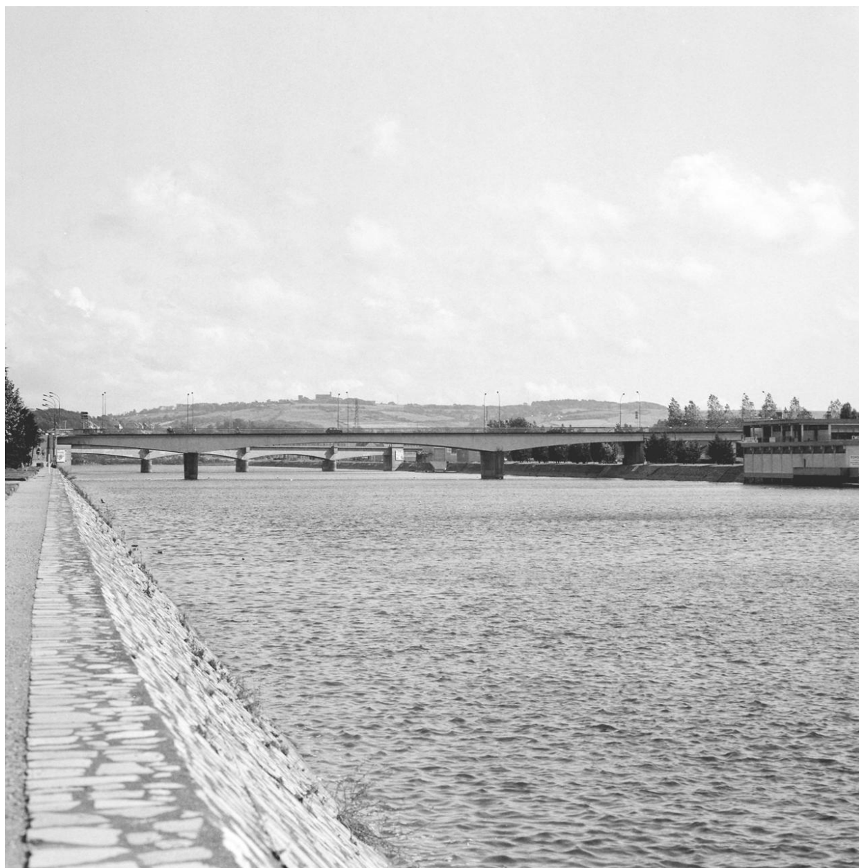
Vue générale nord.
