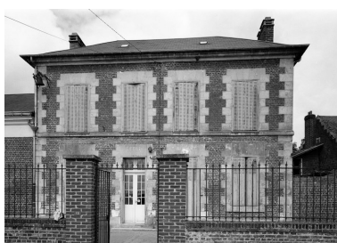
Elévation antérieure. Phot. Jean-Michel Perrin IVR22_19856000976X
