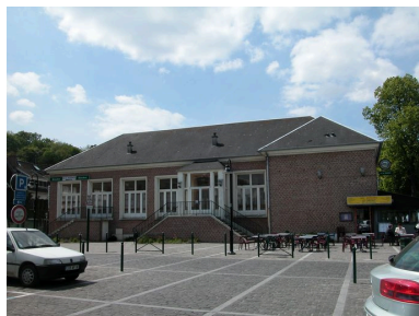
Le casino actuel, à usage de salle municipale, vue depuis la place des Pilotes. Phot. Elisabeth Justome IVR22_20058002869NUCA
