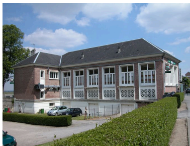
Le casino actuel, à usage de salle municipale, vue depuis le quai du Romerel. Phot. Elisabeth Justome IVR22_20058002870NUCA
