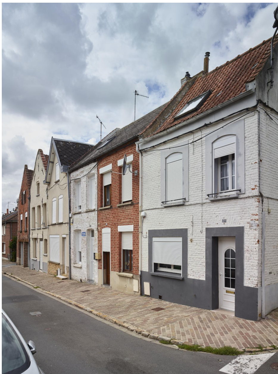
Vue générale des trois maisons insérées dans le tissu urbain de la rue Saint-François. Vue orientée ouest/est.
