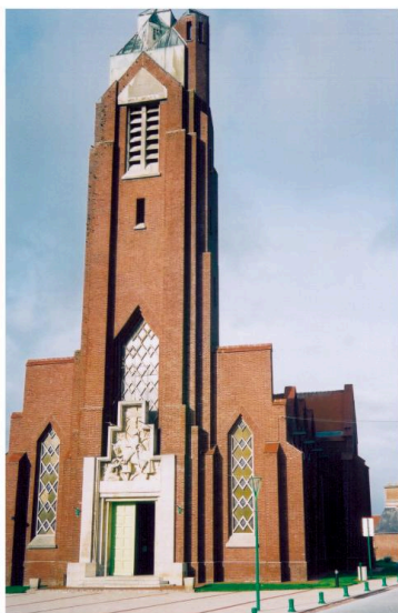
Vue générale. Phot. Gilles-Henri Bailly IVR22_20158005792NUCA
