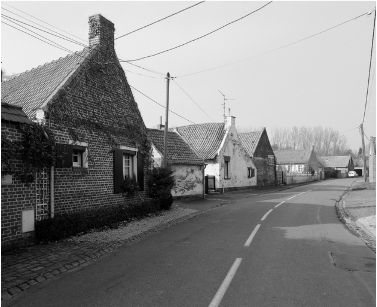
Alignement des fermes rue du Vieux-Condé.
